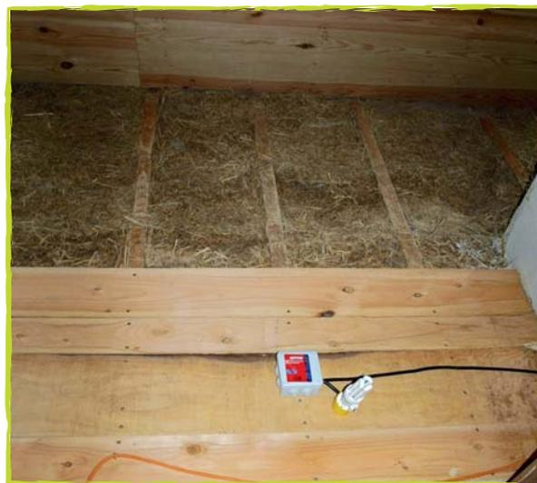
Détail d'une maison à ossature bois - remplissage en bottes de paille compressées.
