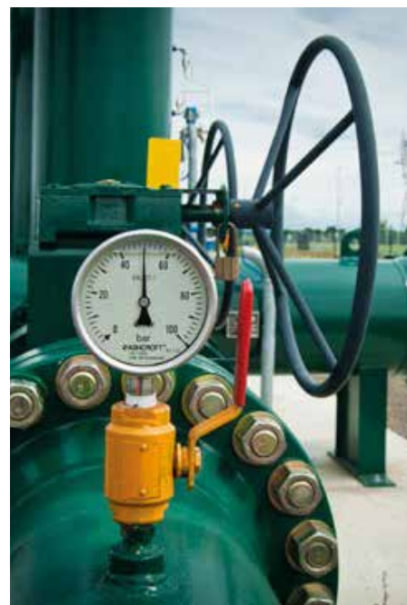
Une jauge de pression sur le réseau de GRTgaz
