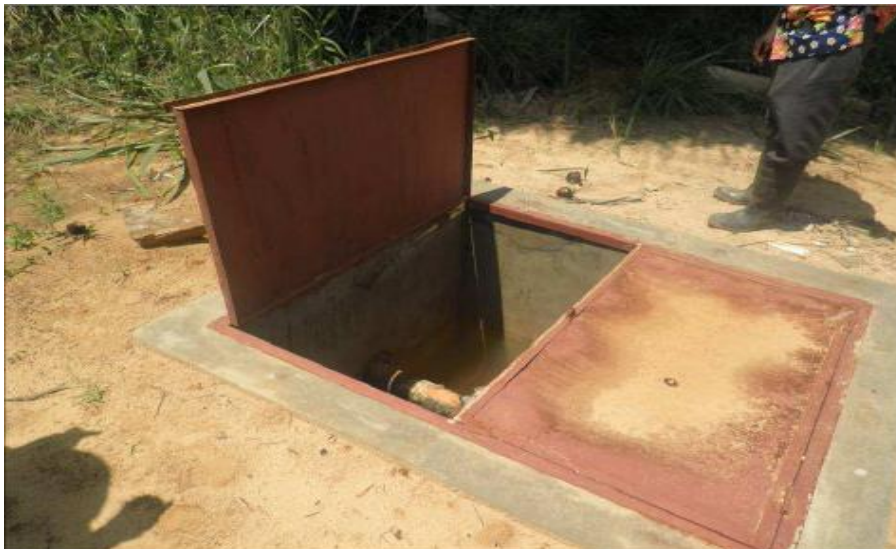
Photo n°26 : Point d'accès de la conduite qui passe dans la rivière 13
