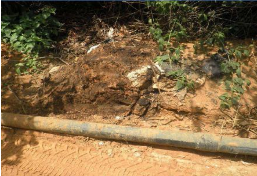
Photo n°43 : Sol pollué par des fuites de pétrole 30
