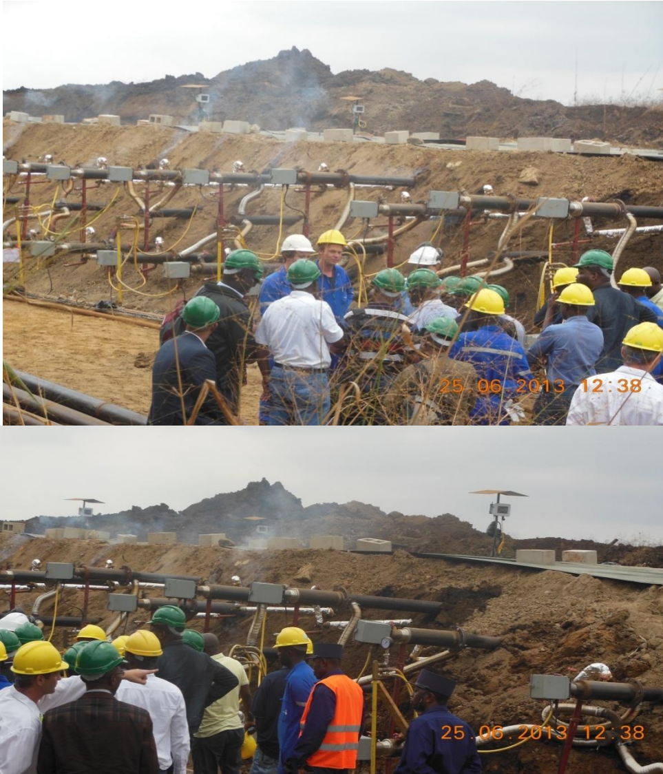
Photo n°76, 77 et 78 : Traitement thermique des sols pollués
