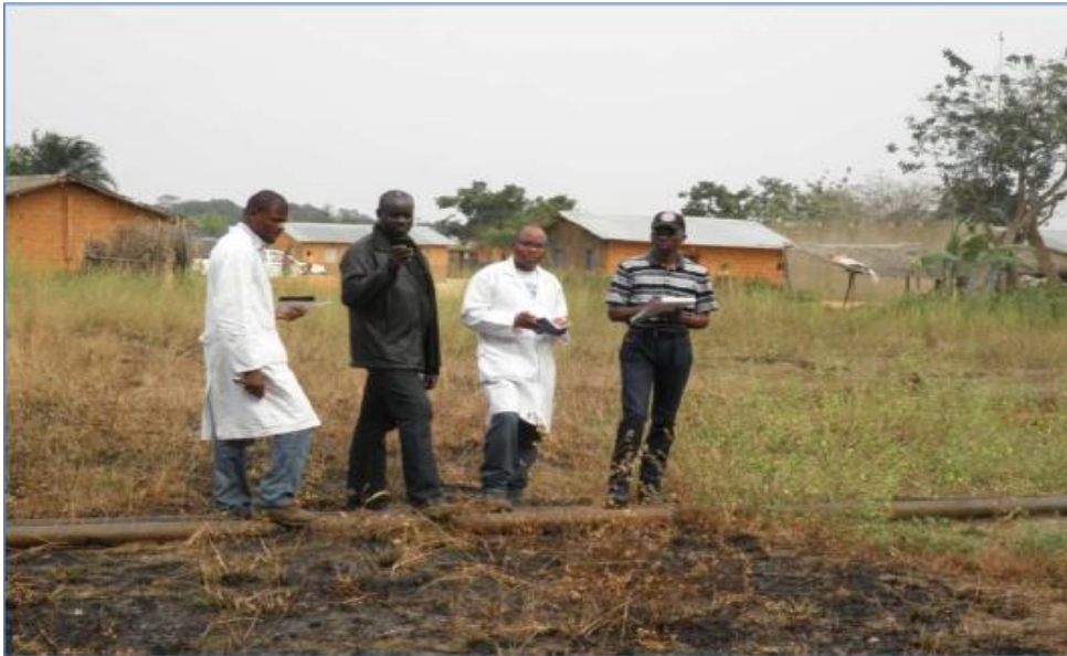
Photo n°41 : conduite de transport du pétrole non enterrée et passant à proximité d'un village 28
