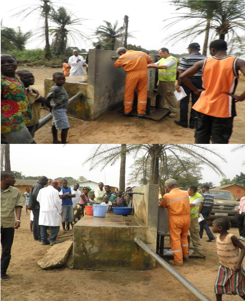
Photo N°16 et 17 : Placement de filtres sur les conduites de bornes fontaines par des agents PERENCO-REP pour faire obstruction à l'enquête de la Commission.
